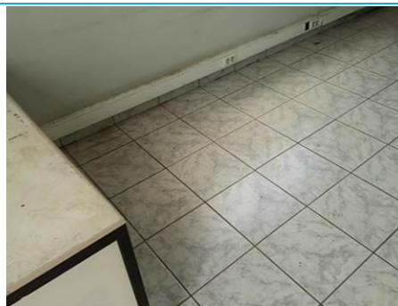
Matériaux : Z06 - Bureau - Plinthe 10x35 - Colle de plinthe Prélèvement : P008 Description : colle de plinthe Localisation : Bureau - Plinthe Résultat : Absence d'amiante
