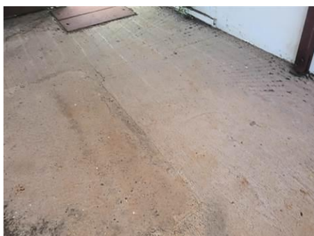
Matériaux : Z03 - Extérieur - Sol - Chappe Prélèvement : P005 Description : Chappe Localisation : Espace terrasse - Sol Résultat : Absence d'amiante
