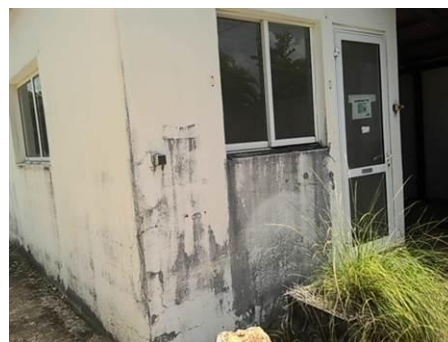
Matériaux : Z01 - Facades extérieures - Mur - Enduit + peinture Prélèvement : P002 Description : enduit + peinture Localisation : Parties extérieures - Facade Est Résultat : Absence d'amiante
