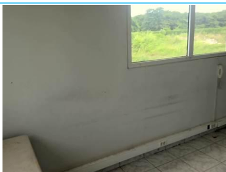
Matériaux : Z07 - Bureau - Mur - Enduit + peinture Prélèvement : P009 Description : enduit + peinture Localisation : Bureau - Mur Résultat : Absence d'amiante
