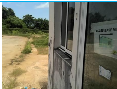
Matériaux : Z04 - Facades extérieures - Embrasement fenêtre - enduit + peinture Prélèvement : P006 Description : enduit + peinture Localisation : Parties extérieures Résultat : Absence d'amiante
