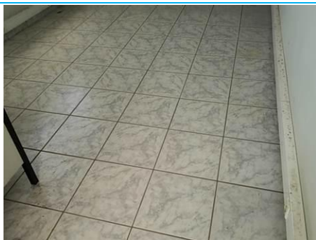
Matériaux : Z05 - Bureau - Sol 35x35 - Colle de carreau Prélèvement : P007 Description : colle de carreau Localisation : Bureau - Sol Résultat : Absence d'amiante
